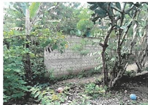
Foto 2: Remozamiento de muro perimetral de block
