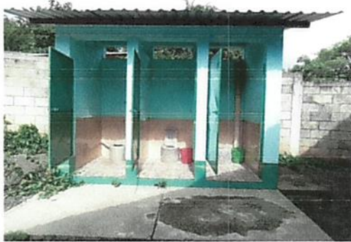
Foto 3: Sustitucion de baños y puertas de baños. Suministro e instalacion de base de metal para colocacion de rotoplas
