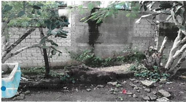
Foto 1: Remozamiento de muro de perimtral de block
