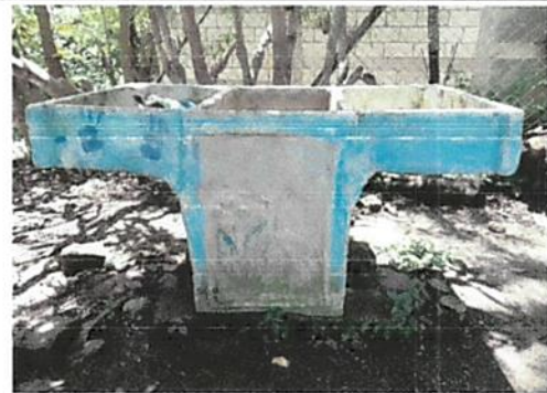
Foto 4: Sustitucion de pila por pila concreto de un lavadero capacidad de 5 toneles aproximadamente
